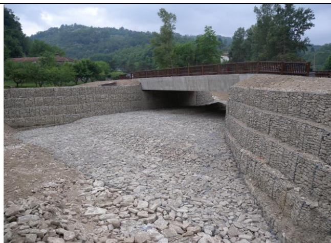
Ponte sul torrente Tatorba, fine lavori giugno 2009
